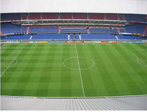
Stadion Feijenoord gezien vanaf de overkapping.
